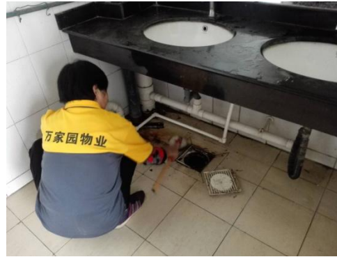
清理下水地漏周围污迹
