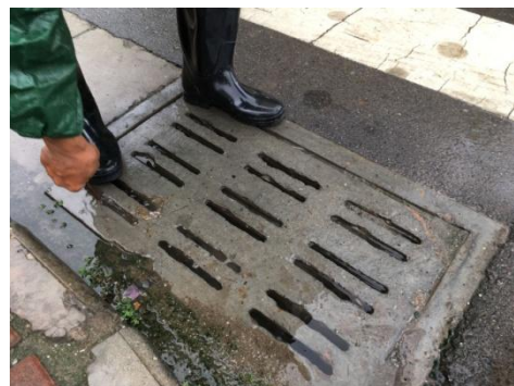
疏通下水井盖口杂物
