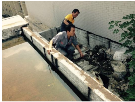
疏通天桥屋面积水
