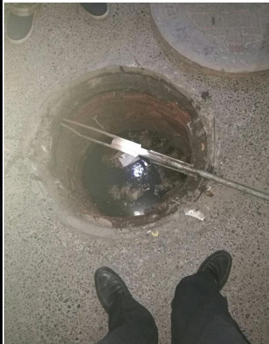
长安校区 5、6 号公寓间下水管道堵塞，造成污水外溢
