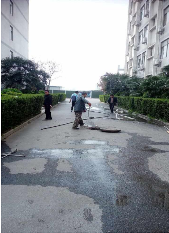
长安校区5、6号公寓楼下水管道疏通， 路面重新恢复整洁
