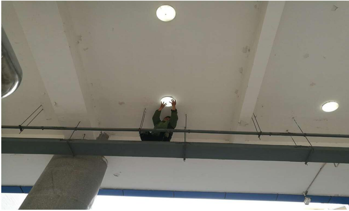
长安校区教学楼 D 区连廊修灯
