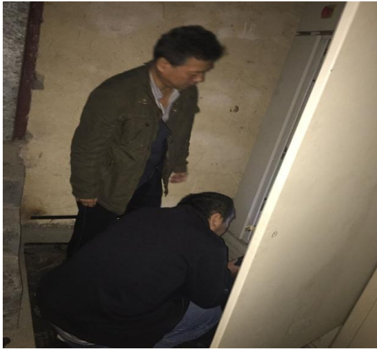
雁塔校区抢修家属区 2 号配电 室查看损坏位置
