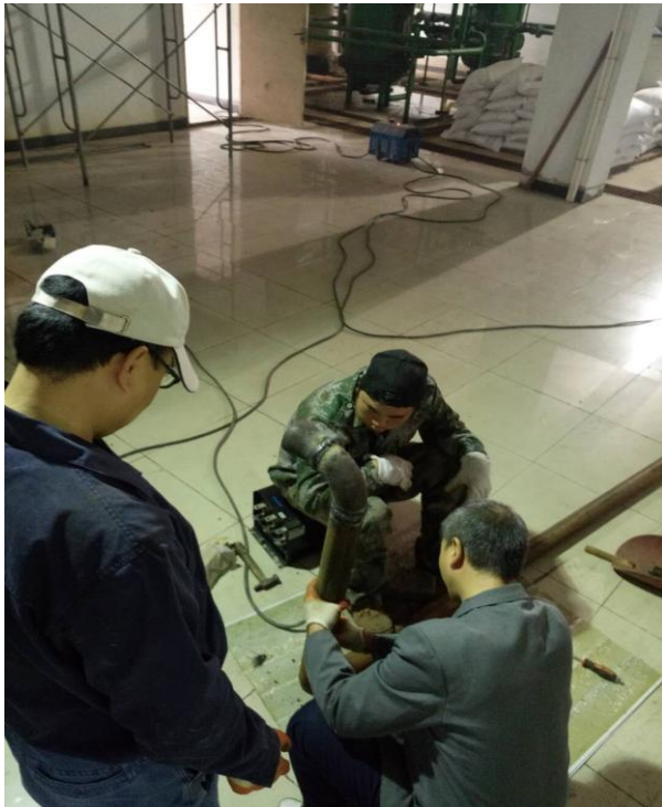
长安校区1号热力中心 抢修锅炉房上水管
