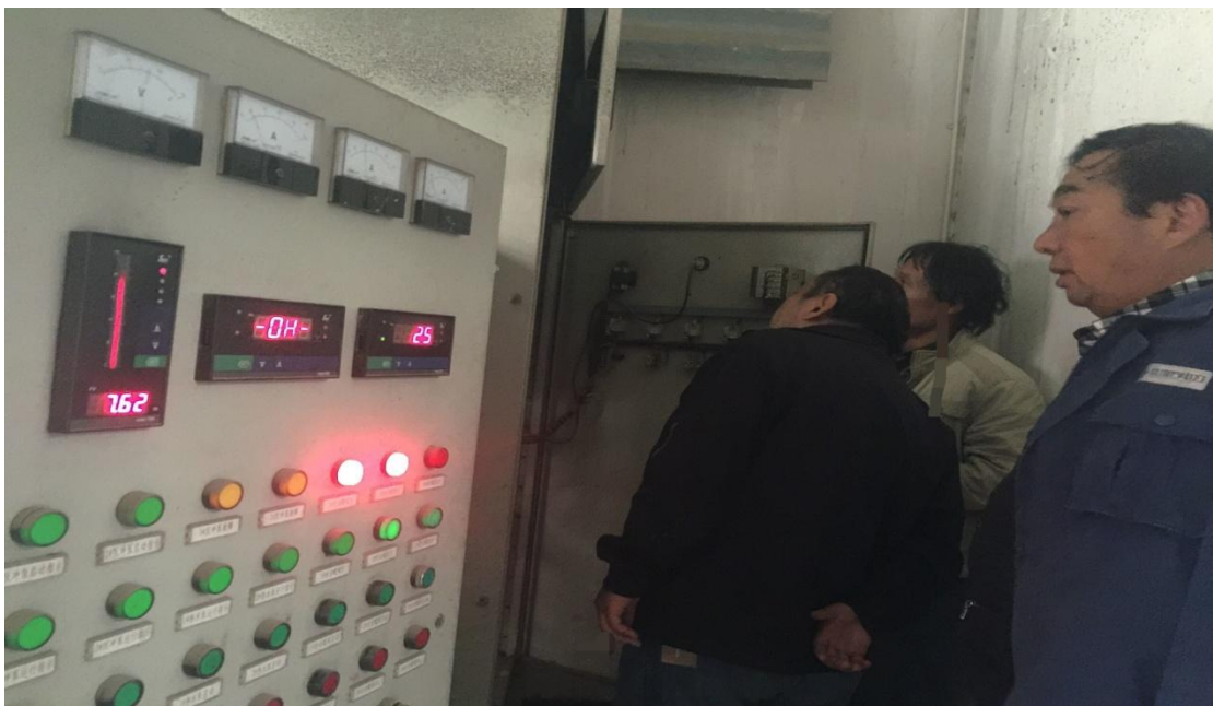
长安校区南区检查水泵房设备运行情况
