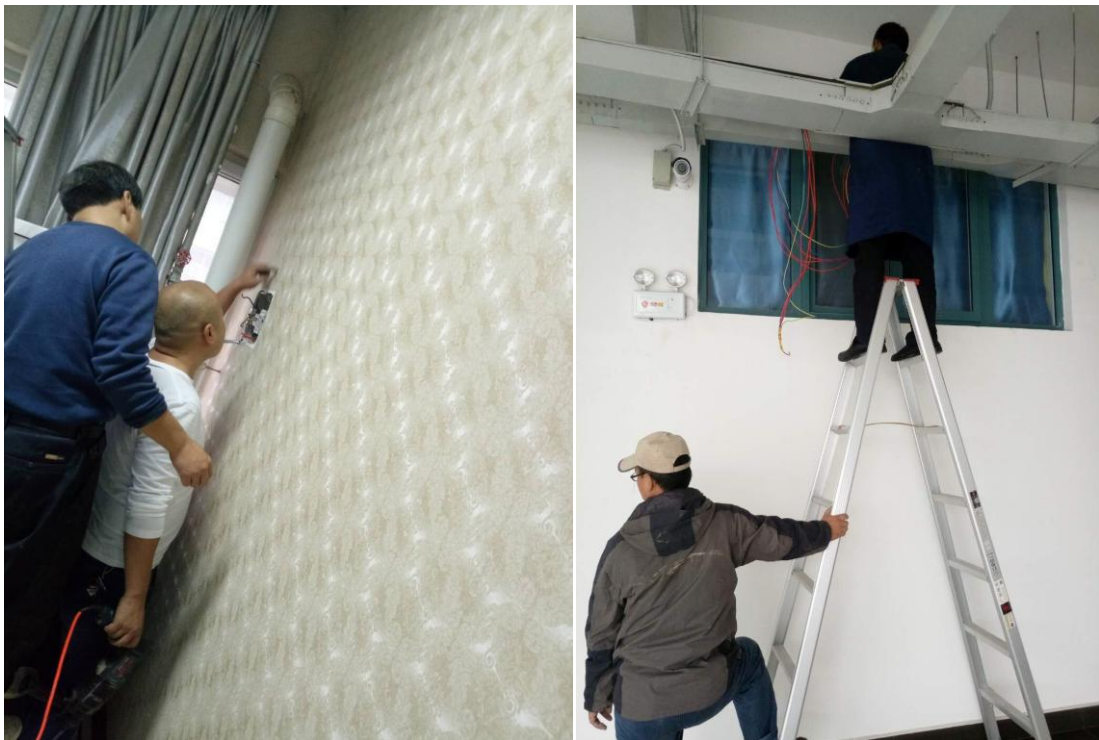
长安校区 SC406 更换空调线路
