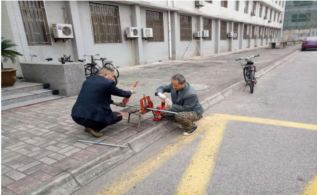
长安校区集团楼安装饮水机布管
