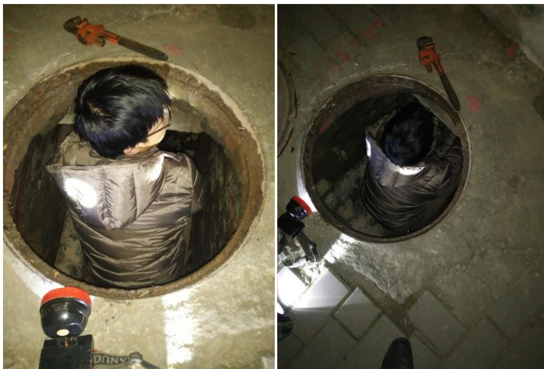
雁塔暖气管道检修
