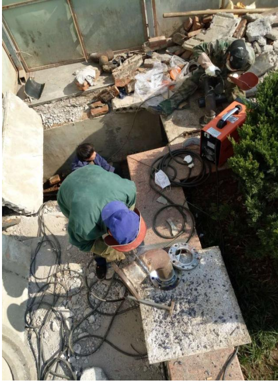
长安校区学生食堂暖气主管 道抢修
