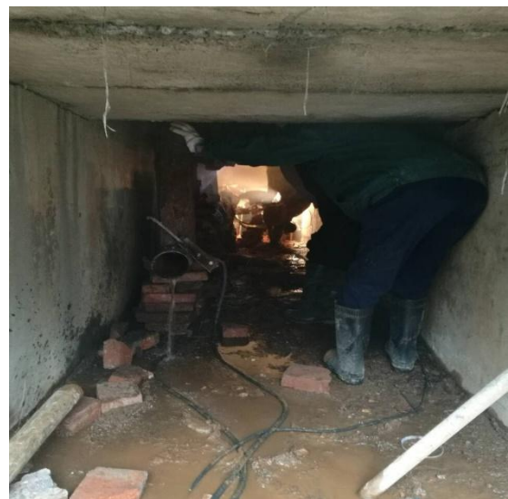
长安校区学生食堂暖气主管道抢修
