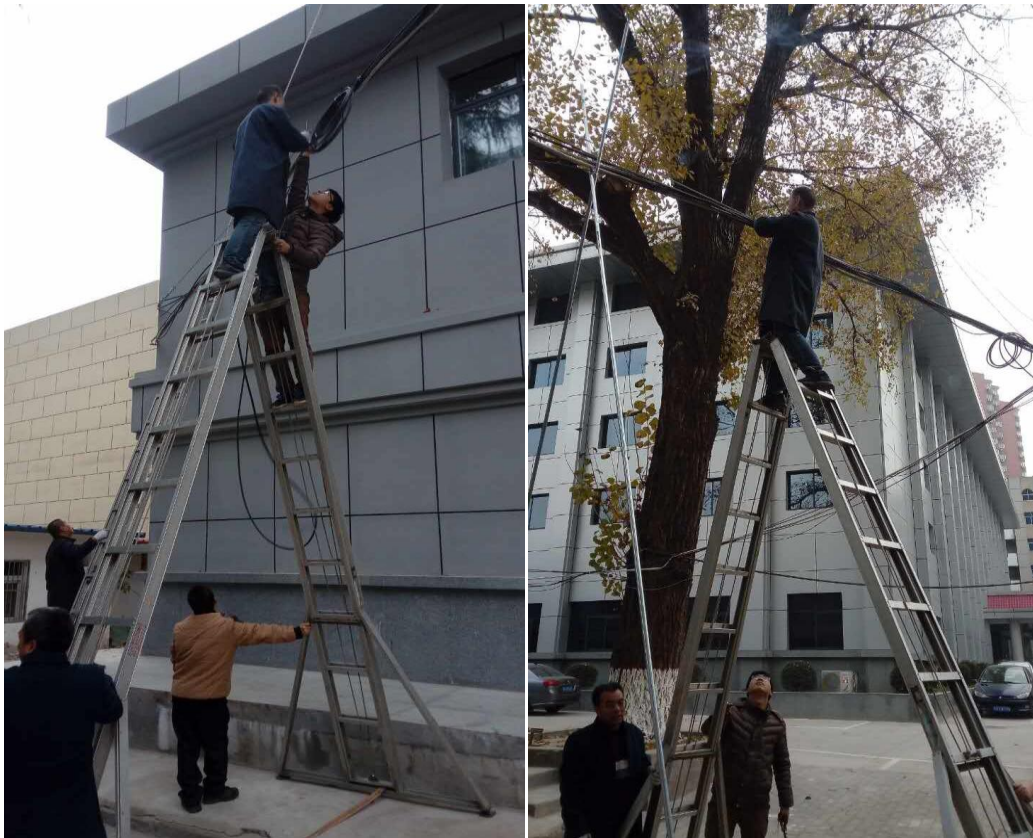
雁塔三号食堂线路改造
