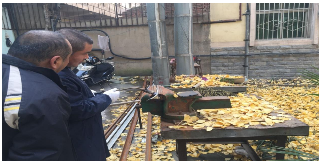
雁塔三号食堂线路改造准备
