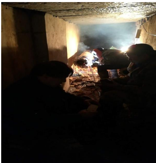
长安校区学生食堂暖气主管道抢修
