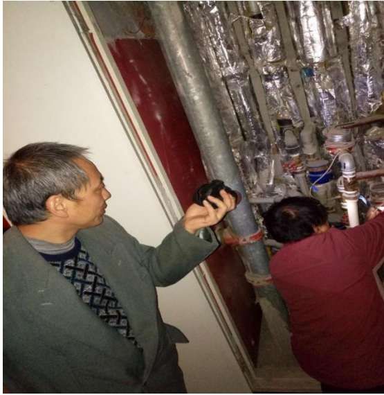
长安校区行政楼暖气主管道 检修
