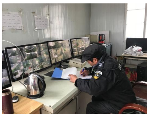
查看、记录监控运行情况
