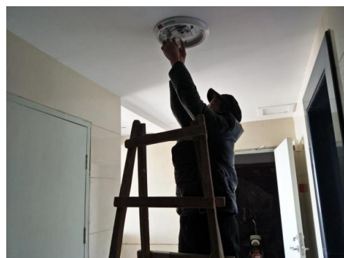
临时处理公区损坏灯管
