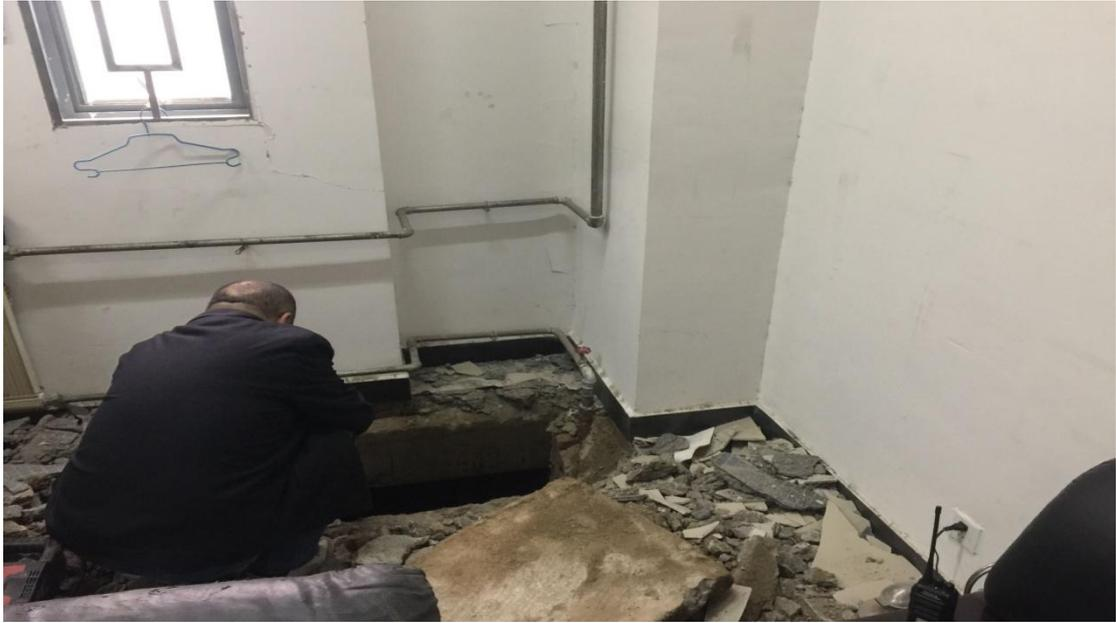
长安校区教学楼 A 区暖气爆管检查漏水点
