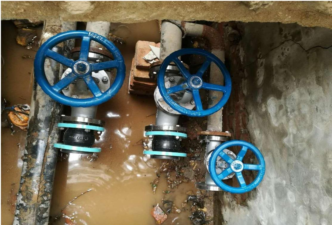
长安校区暖气主管道阀门更换
