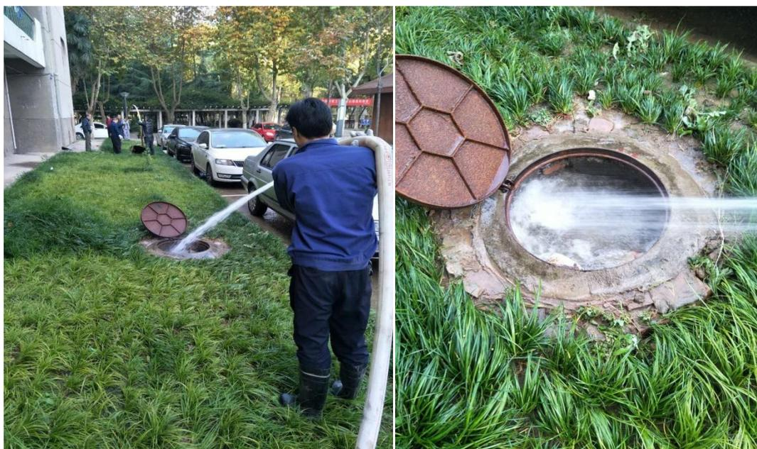
雁塔校区用消防栓水高压冲洗下水管道
