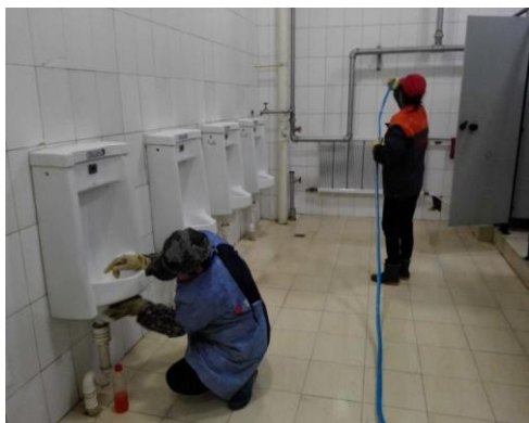
冲洗卫生间墙面
