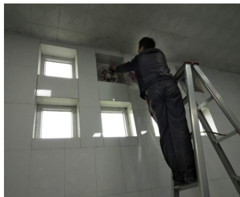
擦拭排气扇灰尘
