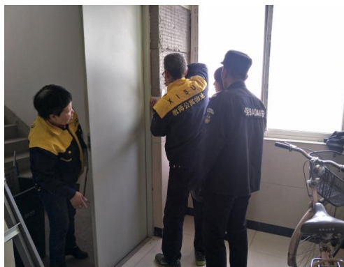
松动墙瓷排查、拆除
