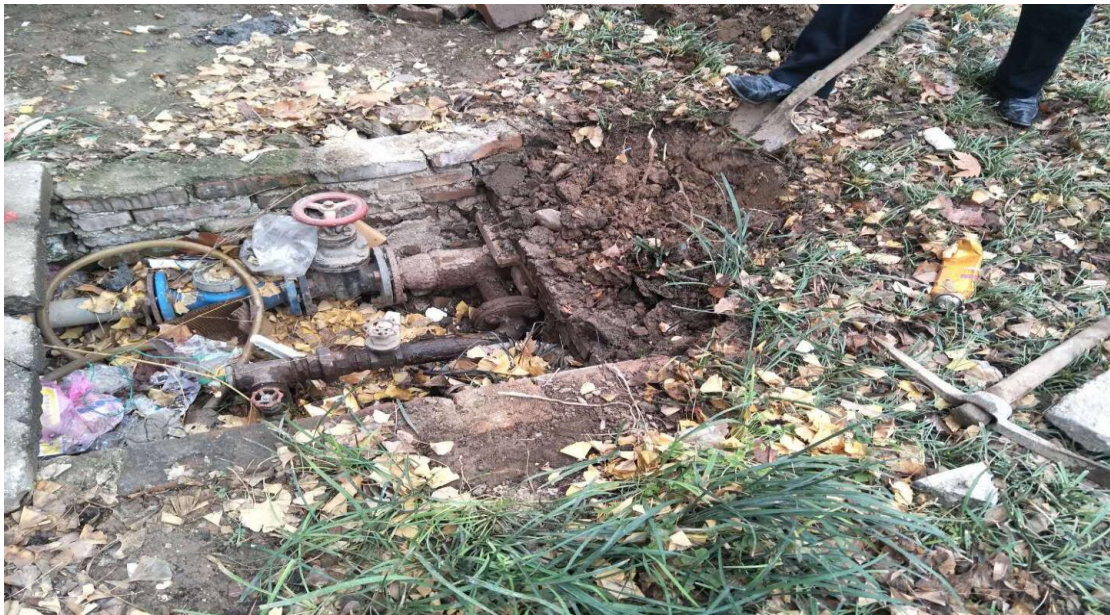
雁塔 6 号男生宿舍楼管道破裂漏水检修
