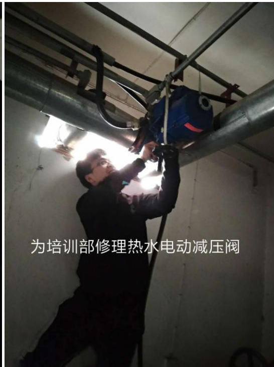
雁塔修理培训部热水电动减压阀
