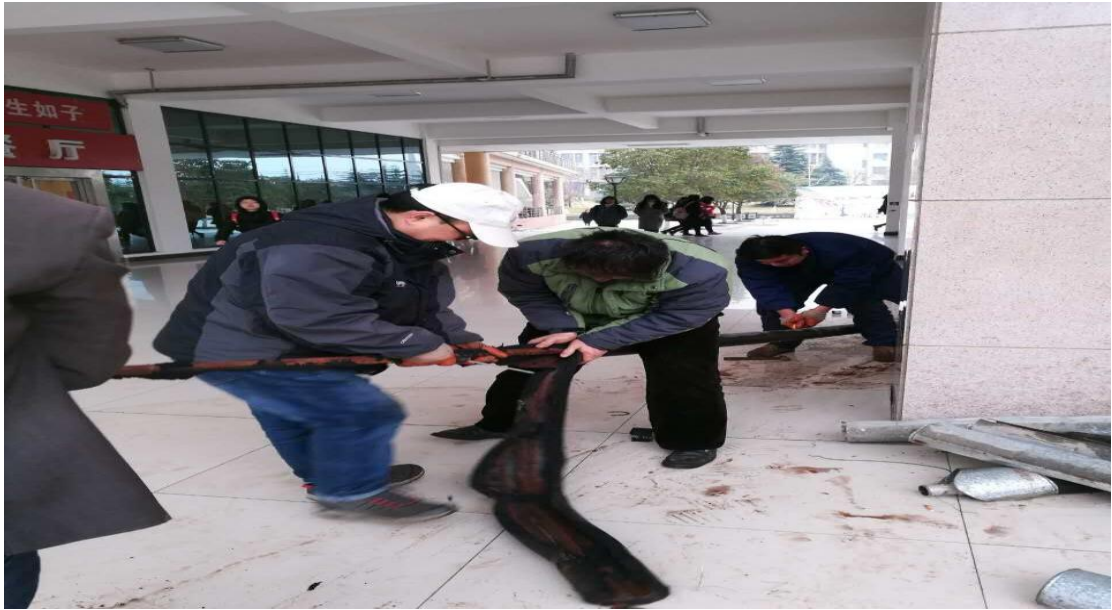
长安活动中心大厅暖气维修
