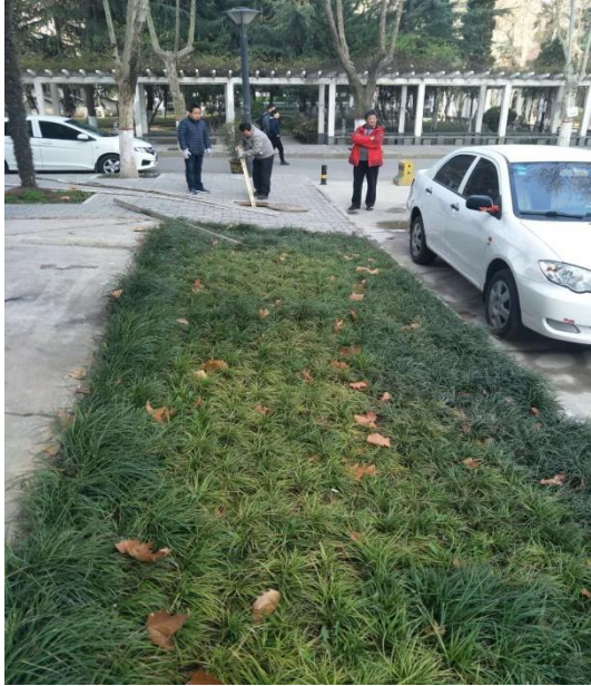
雁塔 2 号公寓下水堵塞疏通
