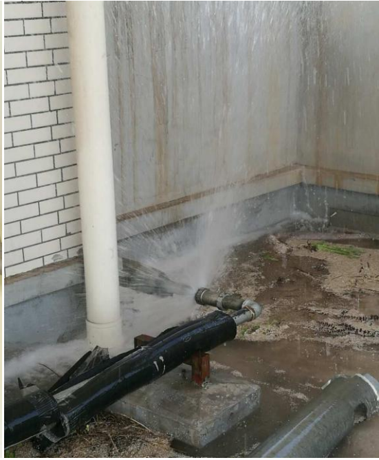
长安2号公寓楼顶上水管爆管抢修
