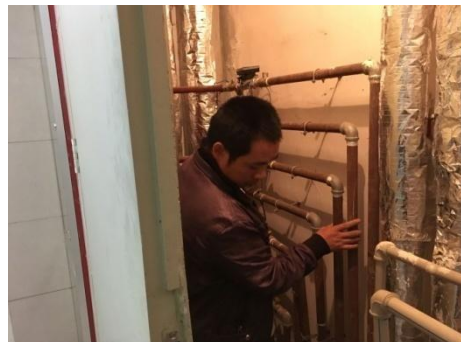
暖气管道排查
