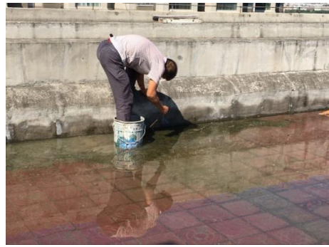
疏通屋面下水口杂物
