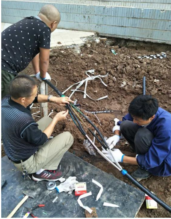
雁塔校区抢修电缆
