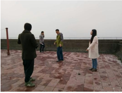
查看屋顶漏水
