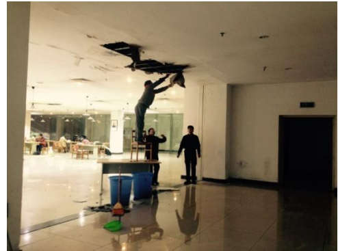
排除安全隐患（图书馆顶板脱落）
