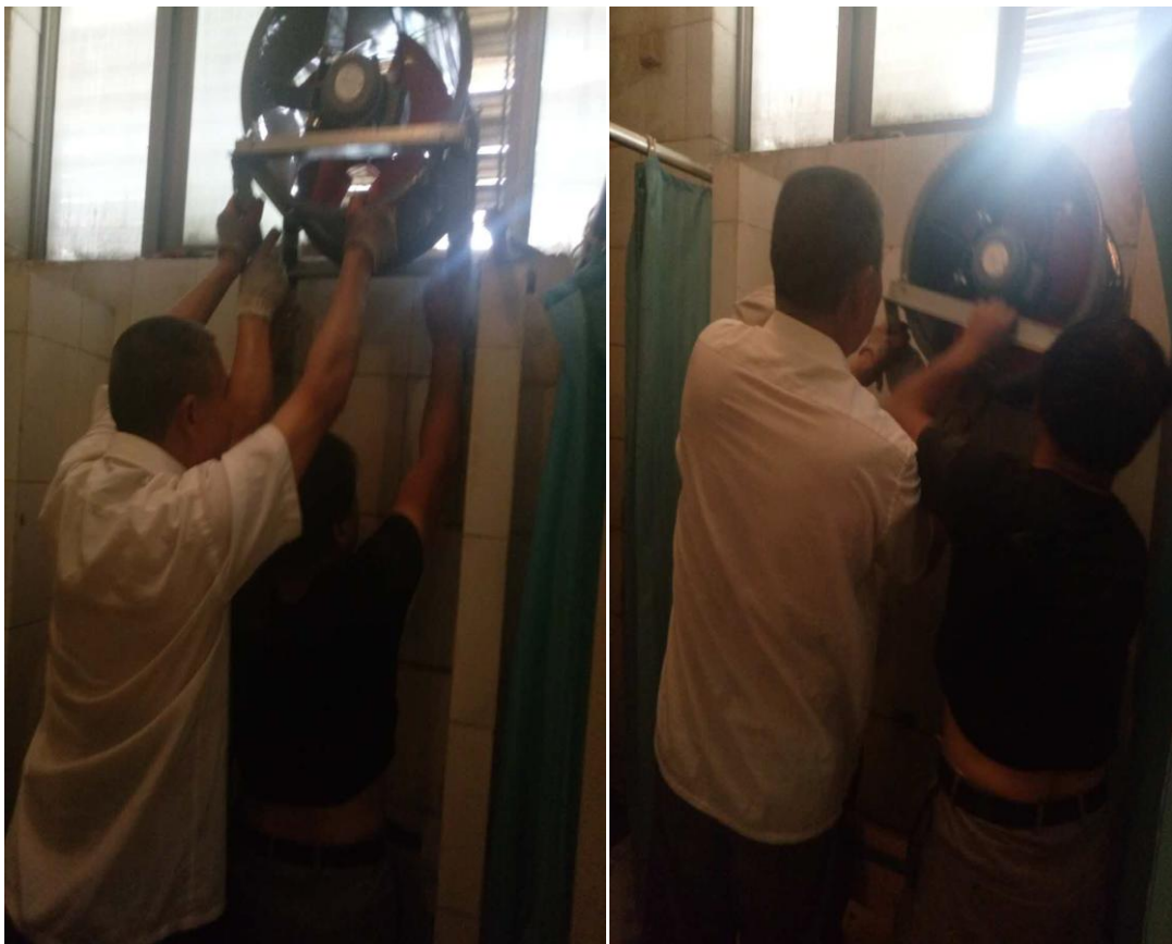
长安校区浴室安装换气扇
