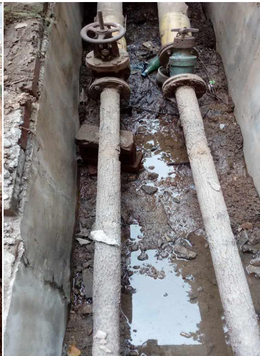
雁塔校区 5 号公寓楼供暖管道更换抢修
