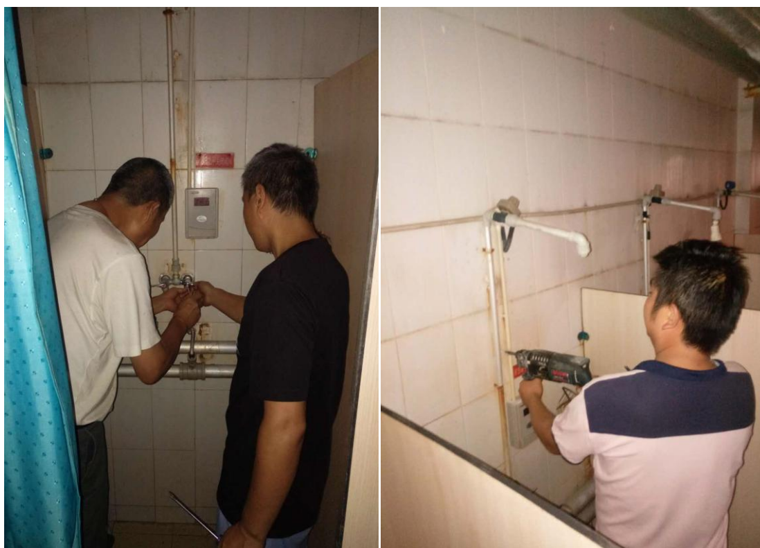
长安校区浴室维修淋浴设施
