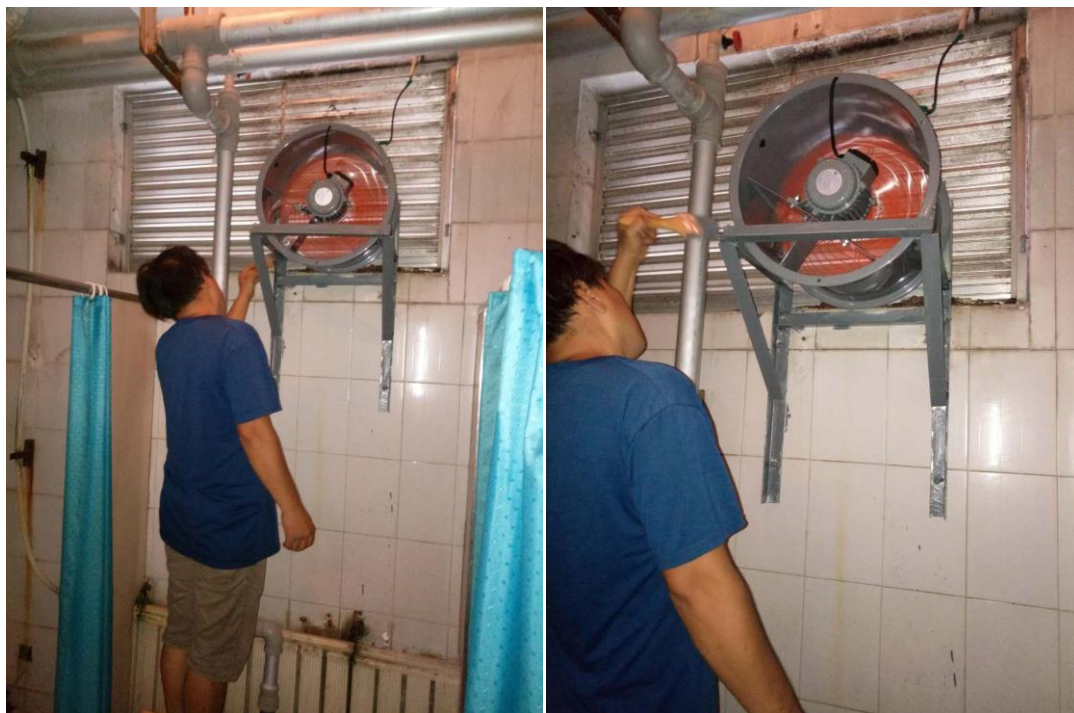
长安校区浴室轴流风机刷防锈漆
