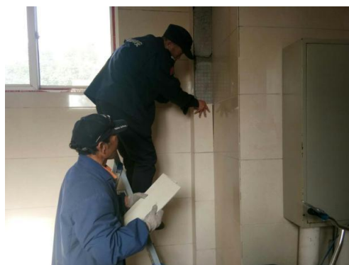
拆除部分松动墙瓷
