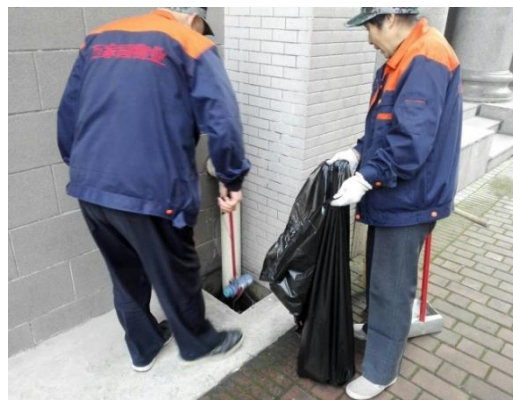
清理教学楼外侧落水口内垃圾
