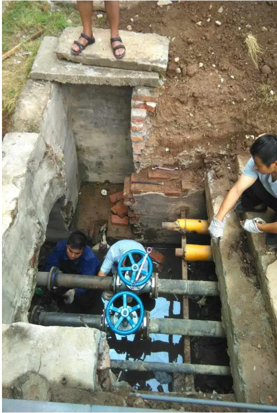
长安校区进出水管道检修
