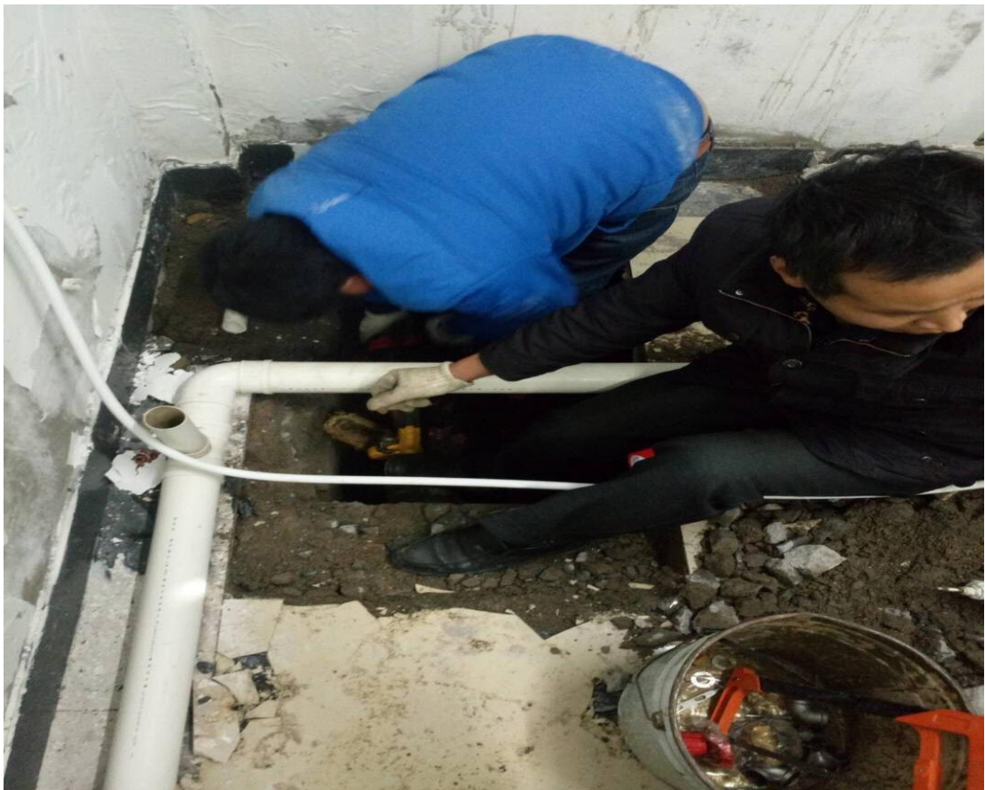
长安抢修 2A 洗衣房地下暖气管道
