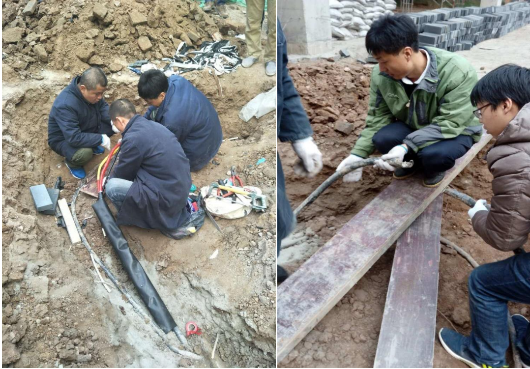
雁塔抢修 7 号教学楼电缆
