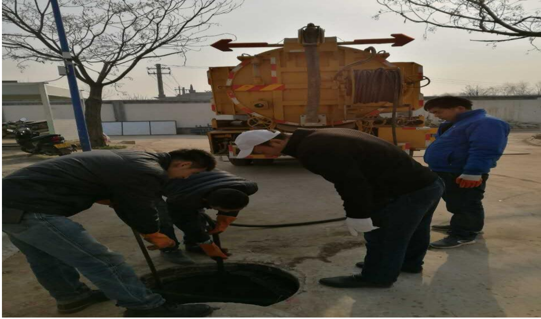
长安疏通苦楝大道下水管道
