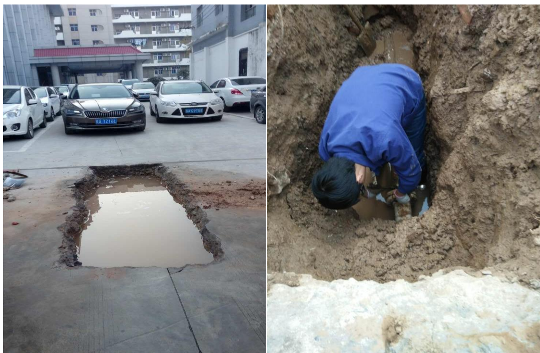
雁塔三食堂上水管抢修
