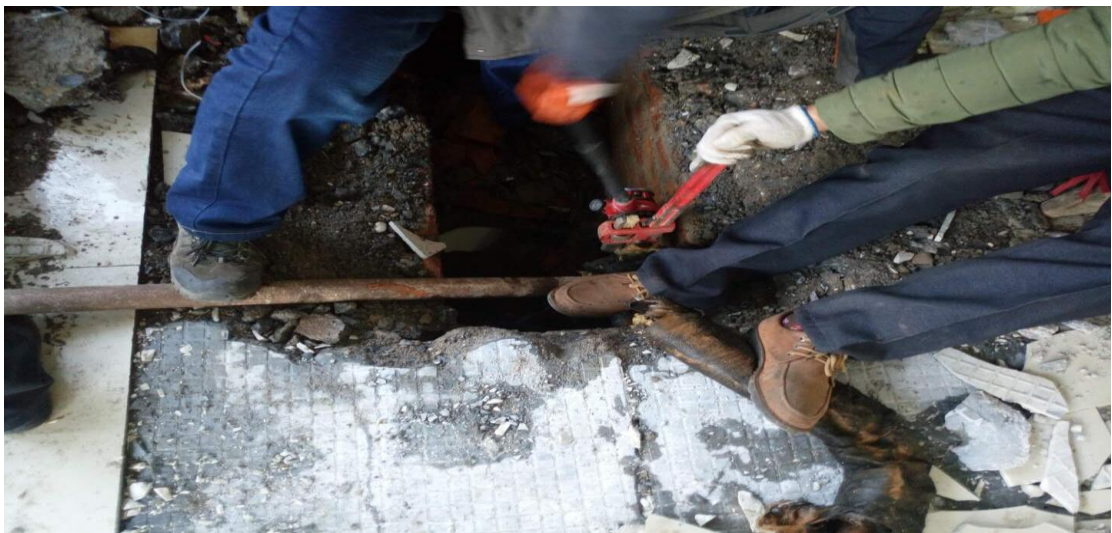
长安抢修 JF 区东暖气管道
