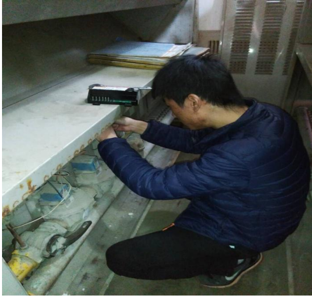
雁塔 1 号锅炉房维修水流 开关
