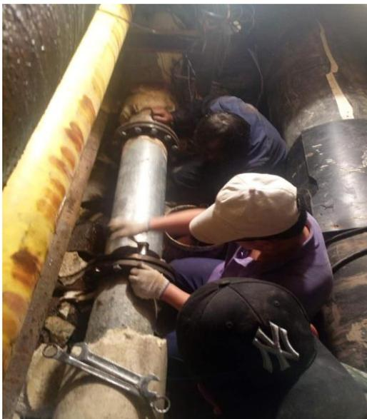
热水管抢修地下施工
