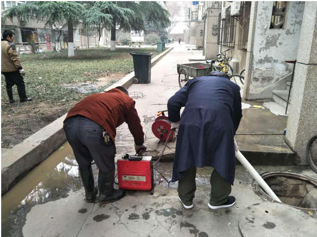
雁塔校区4号楼通下水管道
