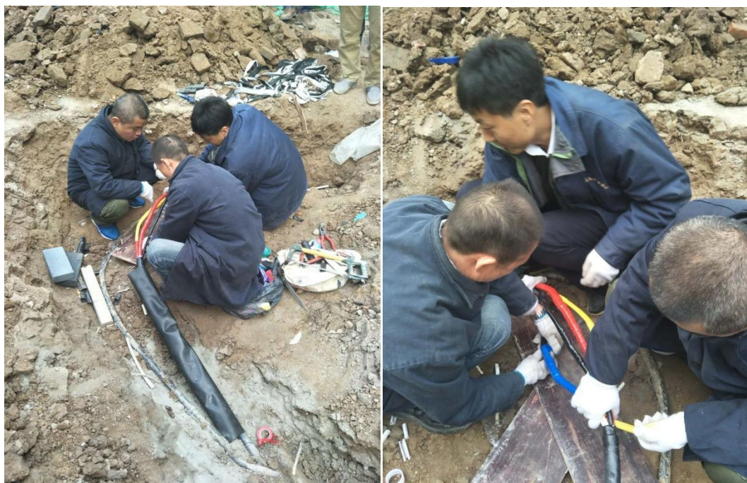
雁塔校区四合院工地电缆抢修
