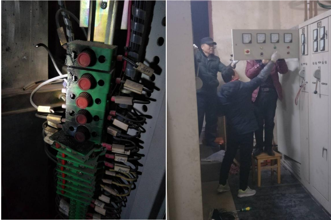
雁塔校区配电室设备损坏维修
