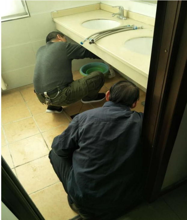
雁塔校区公寓楼更换洗手 池下水管道
