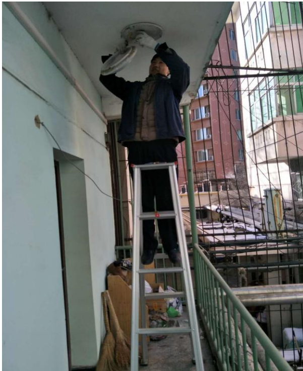
雁塔校区留学生宿舍楼更换灯管
