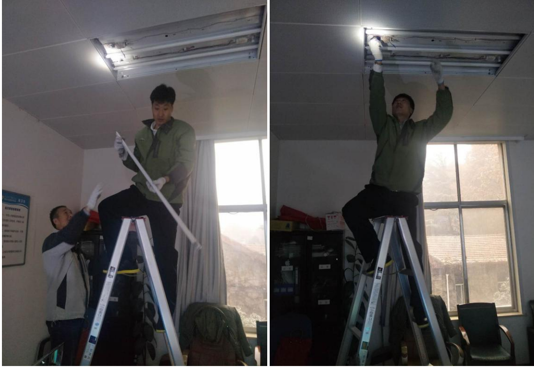
雁塔校区监控室更换灯管
